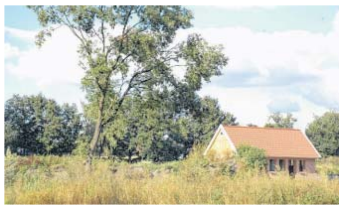
Idyllisch: Das Grundstück des Annette-Schlichte-Hauses umfasst 8000 Quadratmeter. In diesem ehemaligen Hühnerstall im Garten wird die hauseigene Wäscherei eingerichtet.
